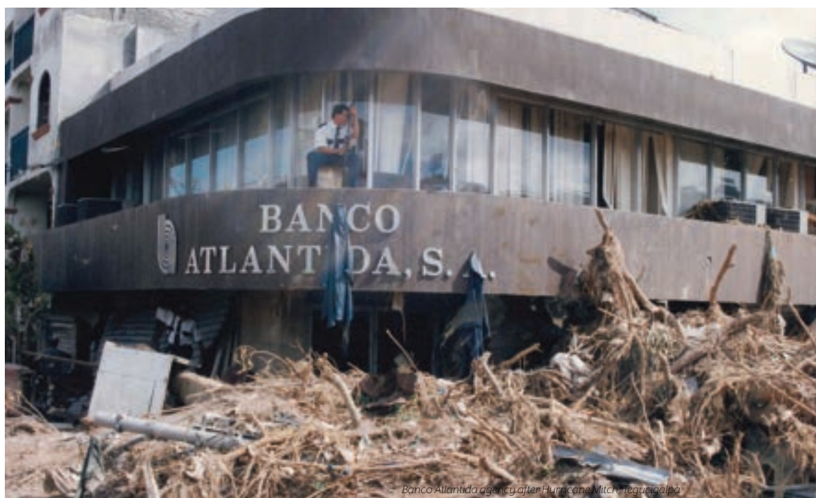
Agencia de Banco Atlántida luego del paso del Huracán Mitch, Tegucigalpa
